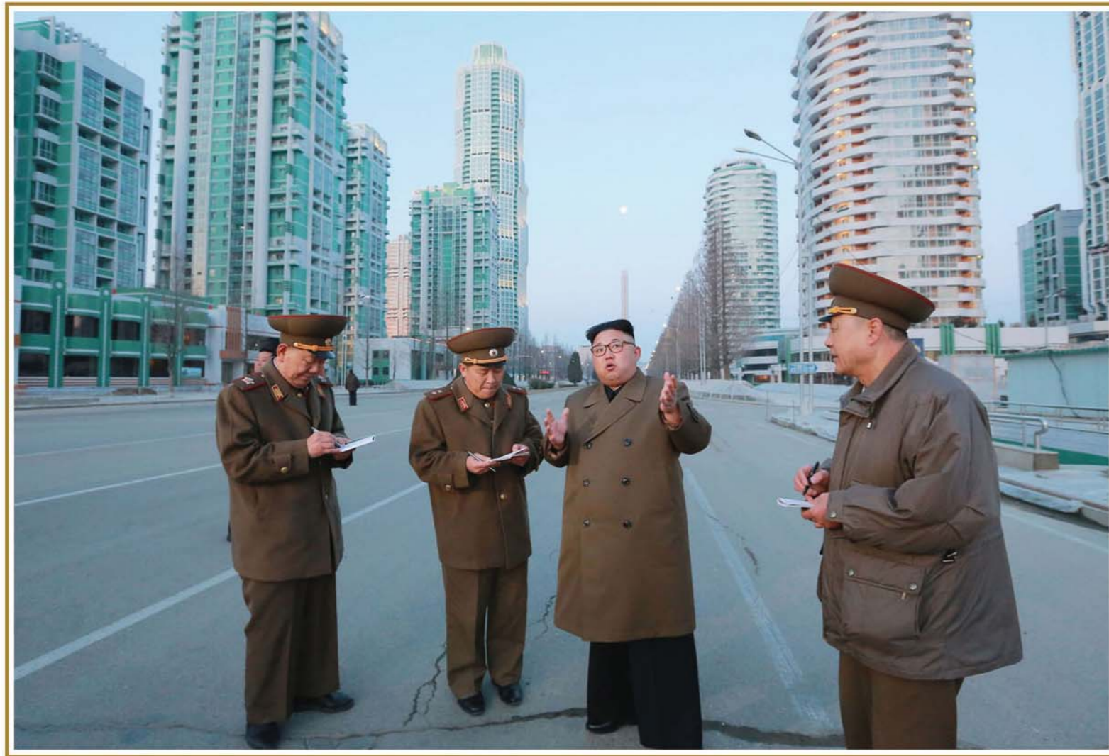
На стройке улицы Рёмён. Март 106 г. чучхе (2017).
